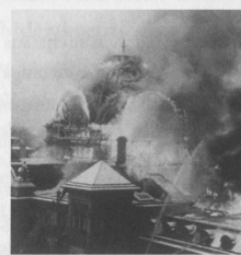
fig. 14 (above), fig. 15 (below)
